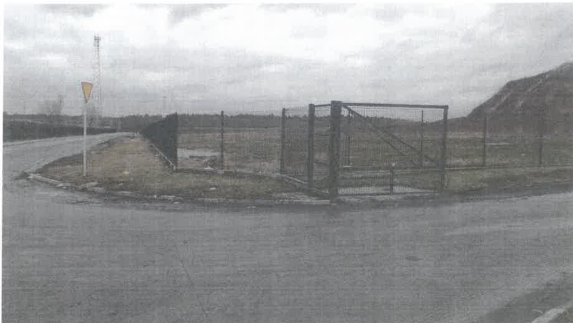
Fot. nr 5 – widok wjazdu lewego – łuk przeznaczony do poszerzenia. Brama wraz z furtką, częścią ogrodzenia oraz ogrodzeniem z siatki (na przestrzeni pomiędzy ogrodzeniem istniejącym a projektowaną bramą) przeznaczone do demontażu.
